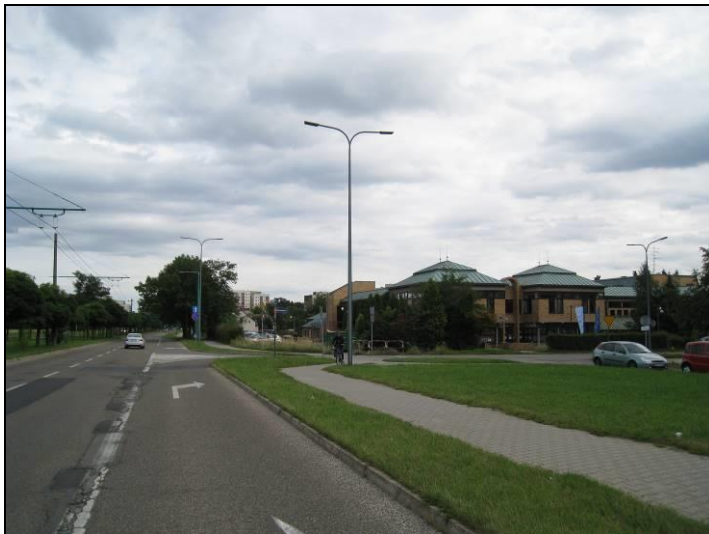
Fot. 1 Budynek w którym mieści się m.in. Dom Kultury, widok od strony Alei Jana Pawła II, od strony zachodniej
