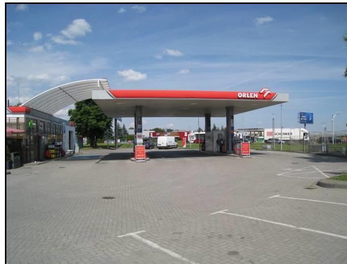
Fot. 3 Stacja paliw w części południowo-wschodniej
